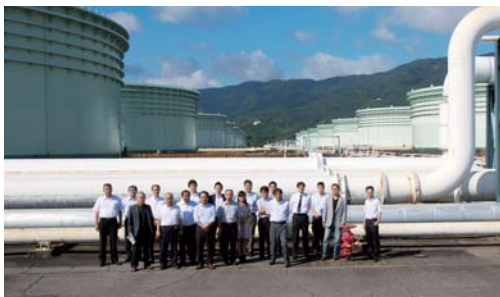
JX日鉱日石石油基地(株) 喜入基地にて
